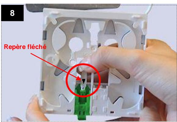
Passer le DiaLink par l'arrière à travers l'ouverture vers l'avant et l'insérer dans l'adaptateur. Veiller à ce que la flèche noire soit en haut et passe dans la rainure de guidage de l'adaptateur.
