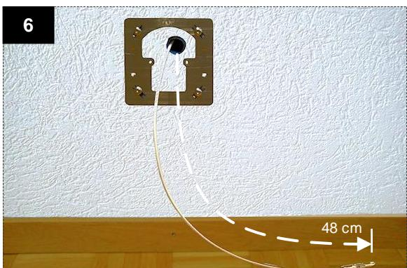
Fissare la placca di fissaggio presa ottica alla parete con 4 viti.
