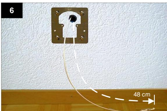
Montageplatte an der Wand mit 4 Schrauben Montieren.
