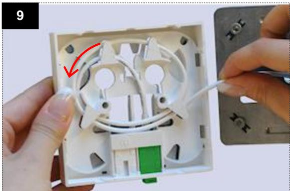
Dose drehen und auf der Rückseite das Kabel sorgfältig unter die Kabelniederhalter einlegen, 2 Umdrehungen nach links.
